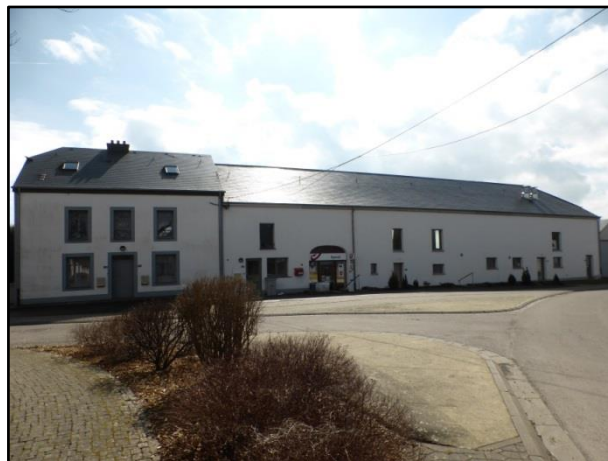
Figure 1.4 Photo de la Maison de la ferme Simon (source : JML, 2018)
