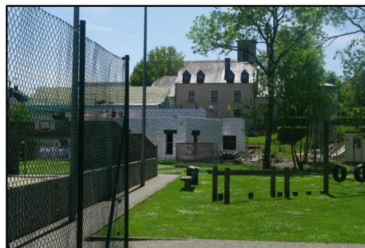
Les travaux dans le centre de Fauvillers (ici le chantier de la crèche en 2018) anticipent les futurs besoins dus à l'augmentation de la population.
