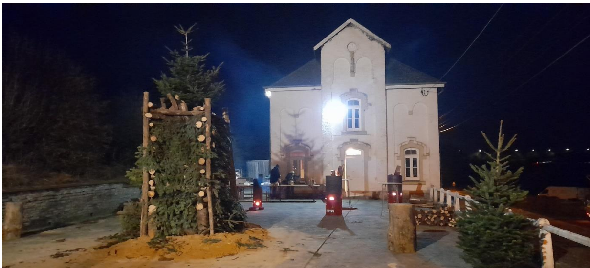
Vue de l'entrée de la salle de village et de la cour à l'avant du bâtiment
